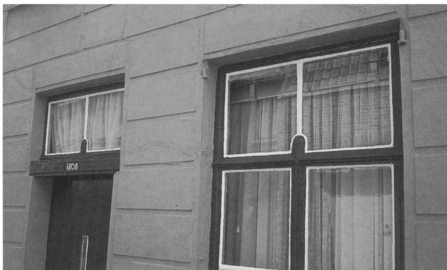
12 Koewacht (België). Halfronde verbreding van de middenstijl van het bovenlicht boven de deur en het draairaam. Gedateerd 1808.
