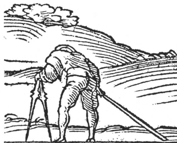
12 Het gebruik van een vloerpasser op de bouwwerf. Walter Ryff (Gualtherius Rivius), Der Architectur fürnembsten, notwendigen angehörigen Mathematischen und Mechanischen Künst .... Nürnberg 1558 (in: Hecht 1979, 250).
