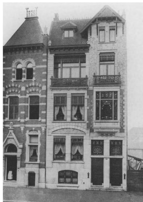
7 Woonhuis aan de van Rotterdam, J.P. Stok 1896 (foto rond 1915). Vollenhovenstraat 29
