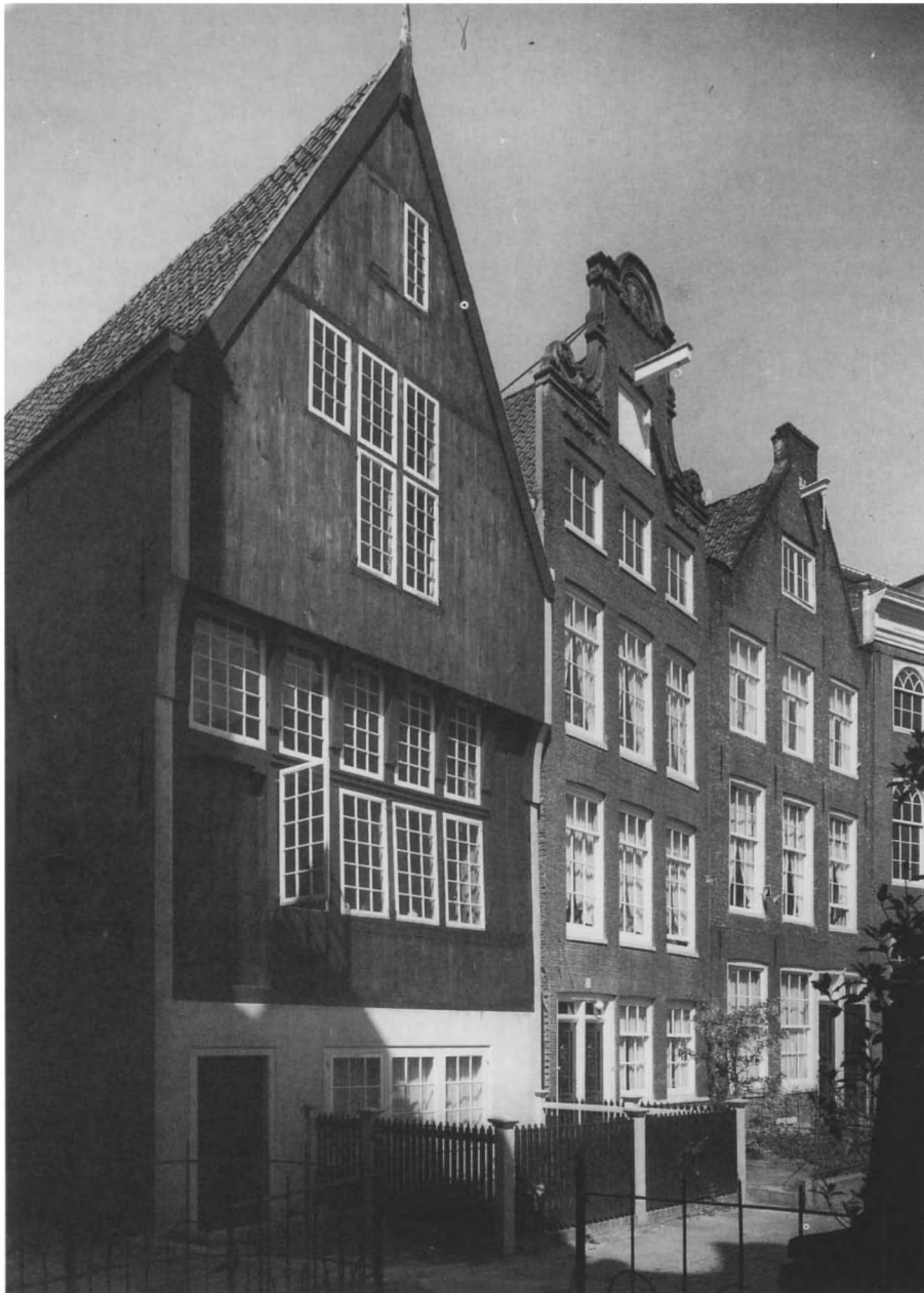
5 Amsterdam, Begijnhof 34. Eerste helft 15de eeuw. Houtskelethuis op stenen kelder of onderhuis. De stenen zijwanden omvatten de houten voorgevel.
