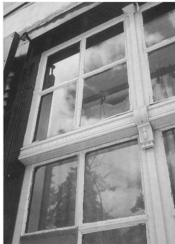
21 Lommel (België), Dorp 16, 1805. Schuiframen met kleine roedeverdeling en brede middenstijl. Console- vormig klosje op geprofileerde wisseldor- pel en op de bovenregel.
