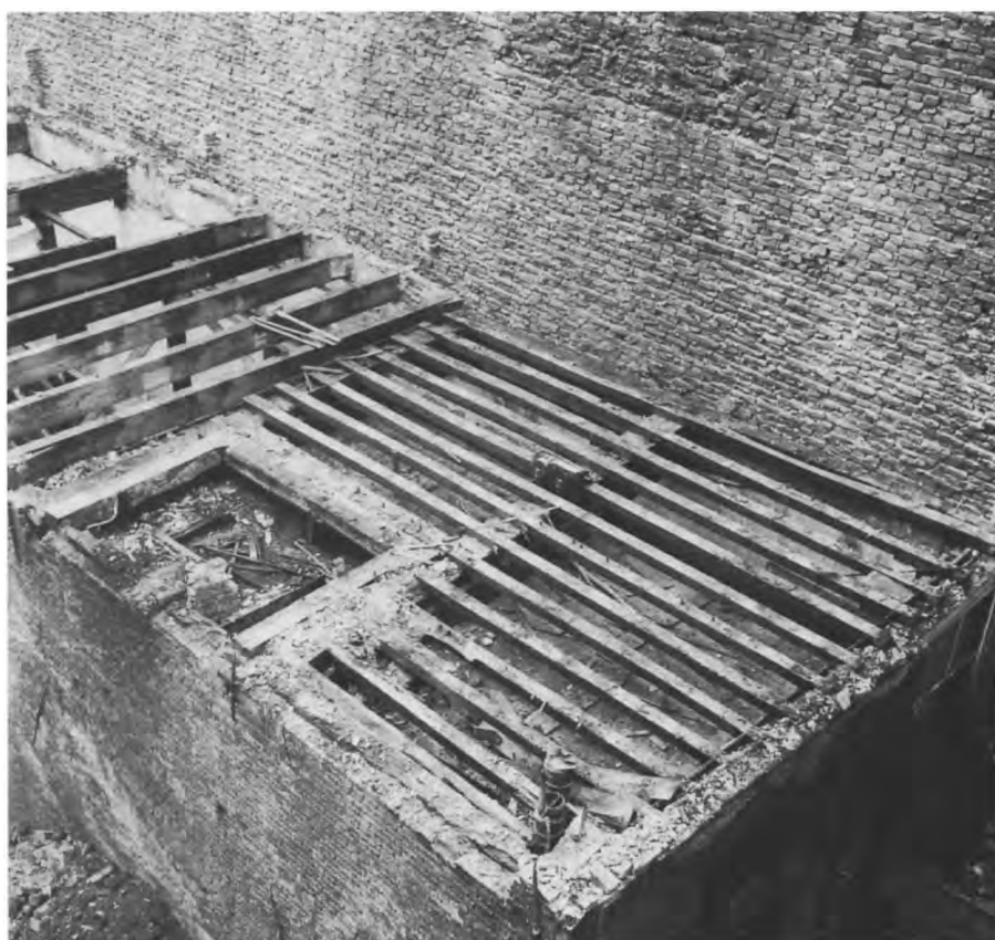
4 Amsterdam, Warmoesstraat 98, Houtskelethuis met dunne stenen wanden, einde 14de eeuw [uit H.H. van Regteren Altena and H.J. Zantkuijl, o.c. (noot 13), plate XXXIX]. Het houtskelet draagt het hele huis behalve de wanden.
