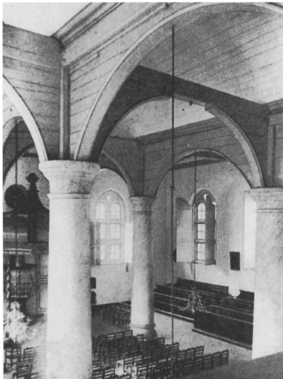
8 Interieur met houten bogen, zoals dit zich vóór 1920 vertoonde (V.I. van de Wall, 1942).
