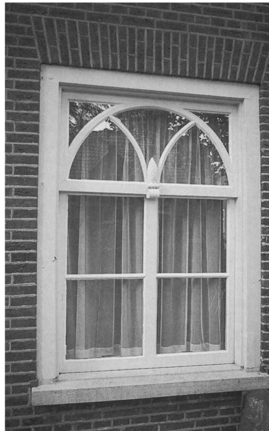
19 Berlicum Hoogstraat, voormalig raadhuis uit 1854 (?). Wisseldorpklosjes met pijnappel. Bovenlicht met open zwikken en gebogen roeden.
