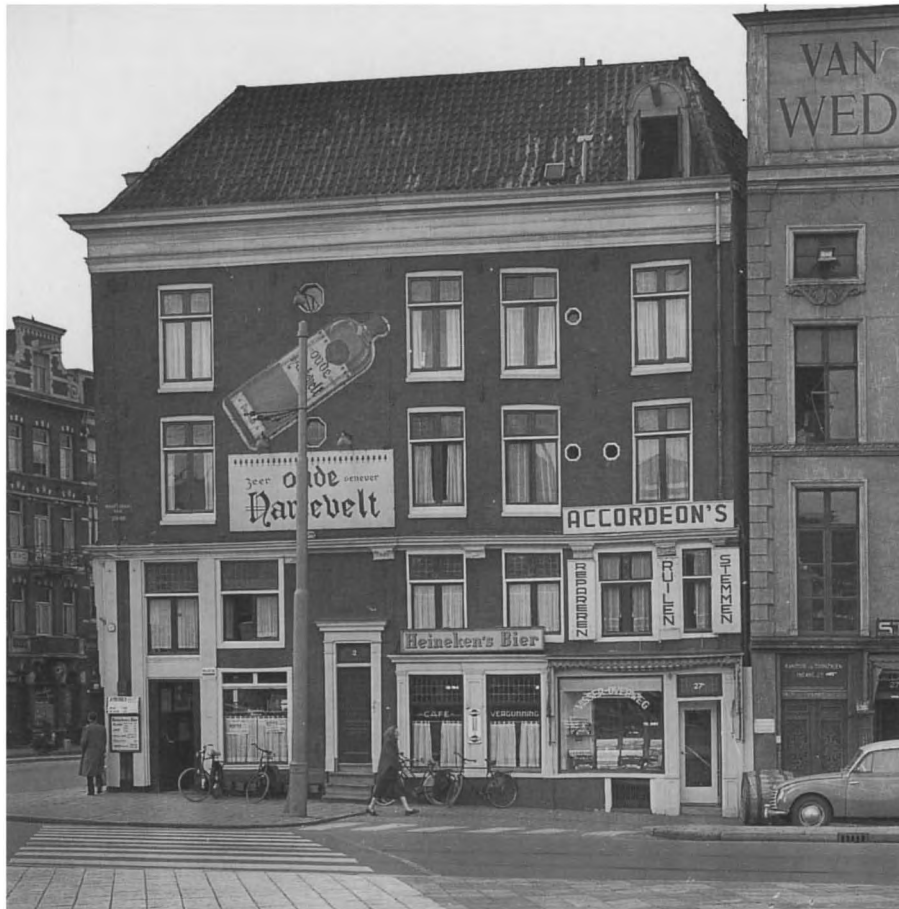
7 Amsterdam, Martelaarsgracht 2, zijgevel aan de Prins Hendrikkade. Anonieme foto in het archief van de RDMZ.
