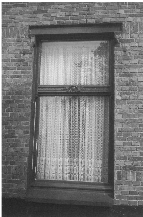
22 Lommel (België), Gestel- sedijk 106/108. Schuifraam met gesneden-geprofileerde wisseldor- pel en zijklosjes.
