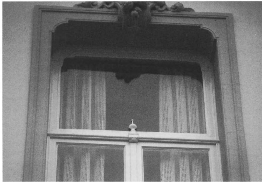
24 Bergen op Zoom, Hoogstraat 25. Wisseldorpel met kwartbolprofieling die doorloopt over het klosje. De middenstijl is voorzien van een lat.
