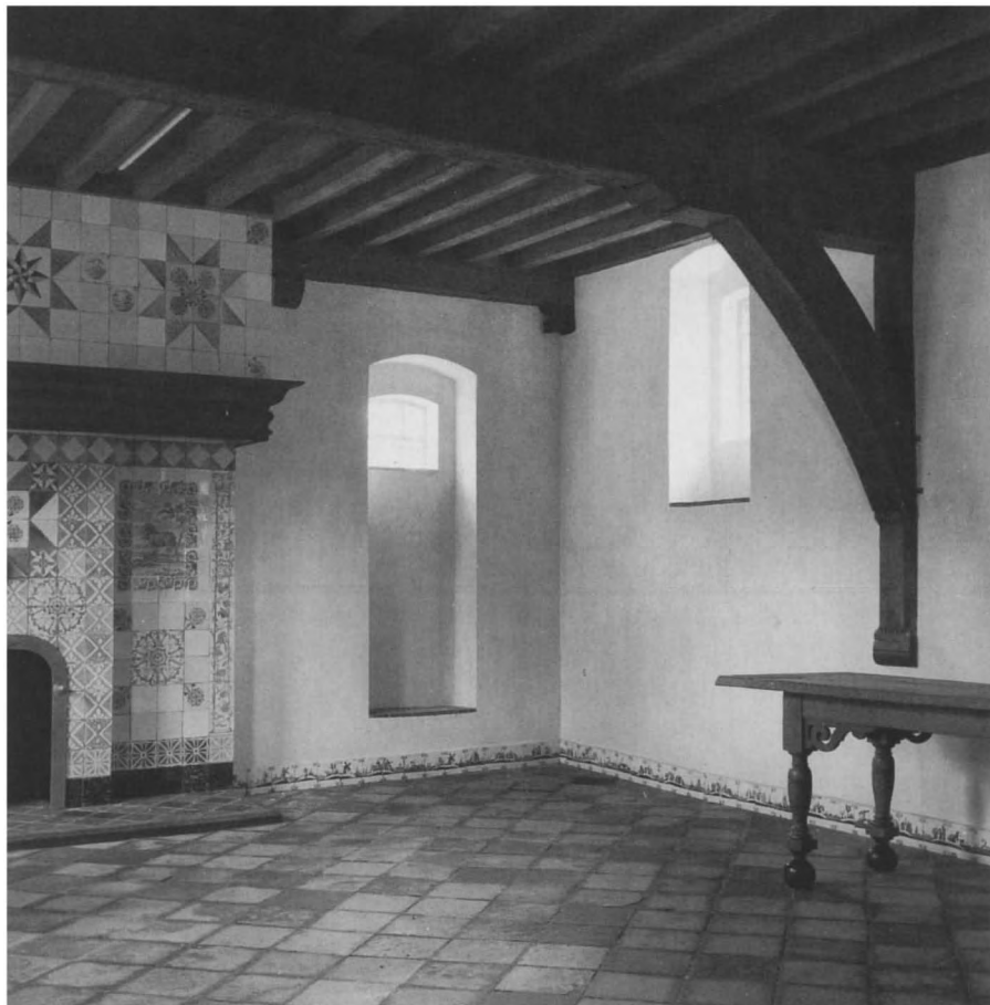
1 Elburg, huis Rozemarijnsteeg. Stenen huis met gebinten die de belasting van de vloeren op het muurwerk overbrengen. Foto C.P. Schaap, 1958.
