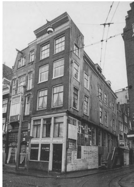
8 Amsterdam, Amstel 116. Pand van ca 1600. Voorgevel in de 19de eeuw vernieuwd. Boven de uitkraging twee volledige verdiepingen. Het inwendige houtskelet is aan de muurankers te herkennen. Foto C.P. Schaap, Gemeentelijk bureau Monumentenzorg Amsterdam (ca. 1960).
