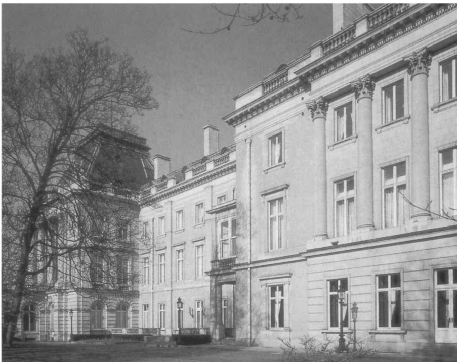
9 Zijgevel tuinzijde van het koninklijk paleis te Brussel, welke dateert uit de periode onder Willem I. Foto L. Schrobiltgen, Brussel.
