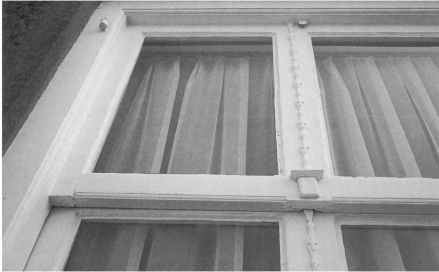
7 Sint Maartensdijk (Tholen), Markt 40. Geprofileerde klosjes, middenstijlen met gesneden afdekklatten, wisseldorpel met kwart-rondprofilering die onderbroken is bij de zijstijlen en de middenstijl.
