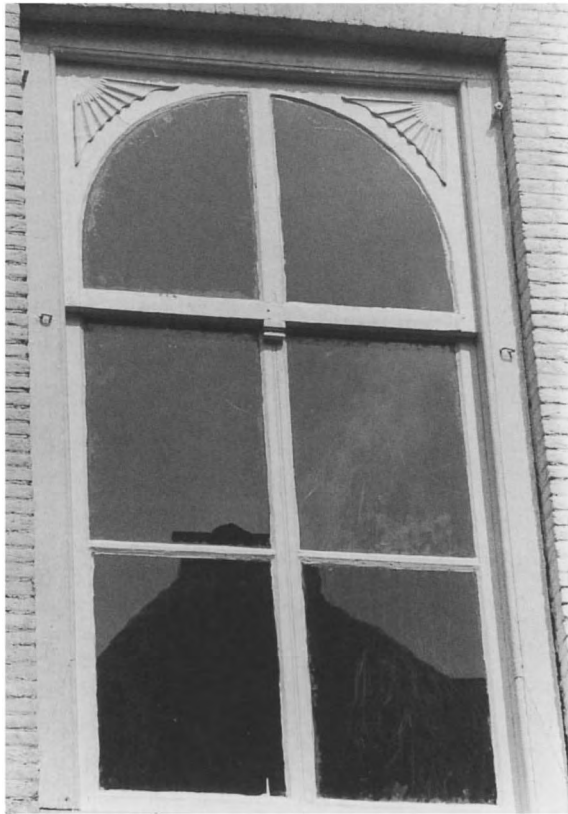
1 Versieringen aan schuiframen, waierzwikken en wisseldorpelklosjes aan het pand Kruisstraat 21 te 's-Hertogenbosch.
