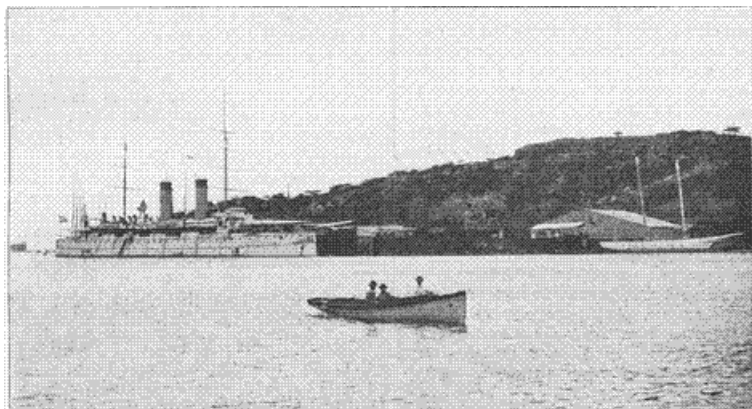
Curaçao: Kolensteiger van de firma S.E.L. Maduro & Zonen. - Links: Hr. Ms. 'Zeeland'.
