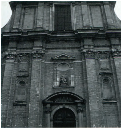
Boven: Detail van de gevel van de Gentse O.-L.-Vrouwekerk van de voormalige Sint-Pietersabdij. [Foto: Brugge, J.L. Meulemeester]
